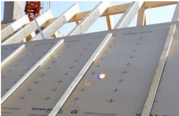
Abbildung 1: Regensicheres Unterdach (nach ZVDH)
