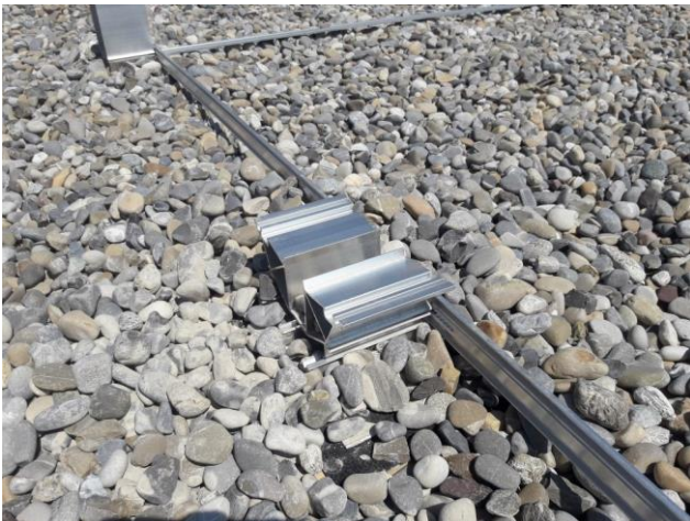
Bild 7: Stütze mit montierter Verbindungsschiene
