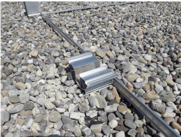
Image 7: Support avec barre de raccordement montée
