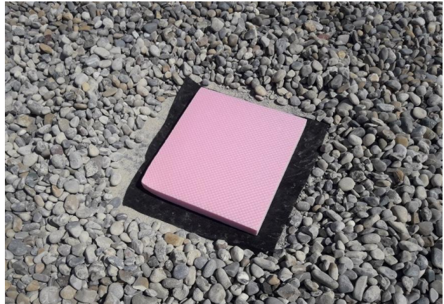
Image 4: Placer la couche intermédiaire en XPS, avec, au-dessous, une couche de protection en non-tissé (si nécessaire)
