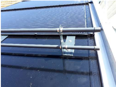
Abb. 5: Traufbereich mit Schneefang auf Blindmodulen
