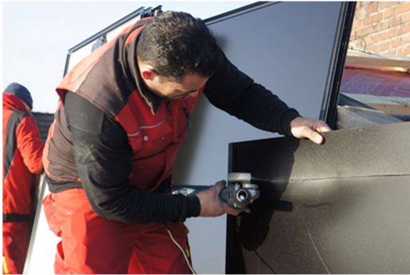
Abb. 10: Zuschnitt Blindmodul auf der Baustelle
