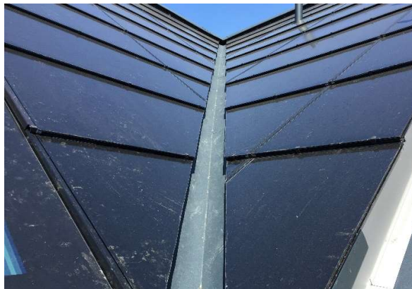
Abb. 2: Ausbildung einer Dachkehle
