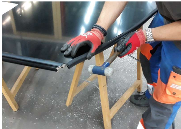
Abb. 13: Aufgestecktes Stahlband als Abschluss der Schnittkante
