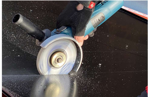
Abb. 11: Zuschnitt mit Flex
