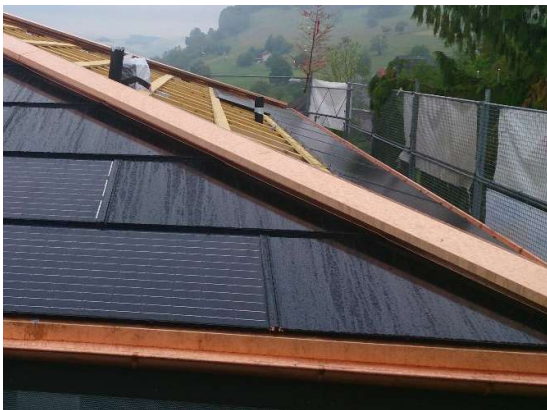
Abb. 1: Abschluss zum Grat eines Walmdaches
