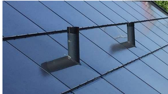
Abb. 6: Blindmodule mit Durchbruch für Abzüge
