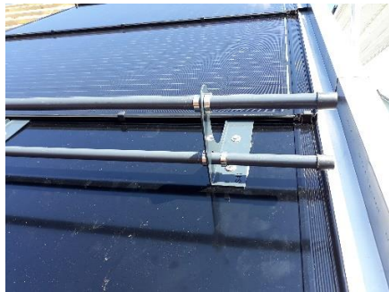
Fig. 5: Zone d'égout avec dispositif de retenue de la neige ancré sur des modules factices
