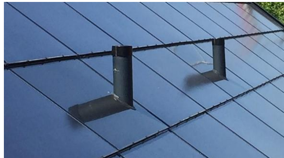
Fig. 6: Deux modules factices ayant chacun un orifice pour le passage d'un conduit de ventilation
