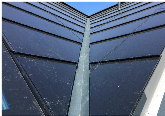
Fig. 2: Réalisation d'une noue
