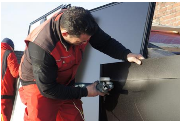
Fig. 10: Découpe du module factice sur le chantier
