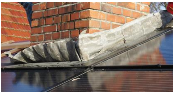
Fig. 3: Jonction avec la cheminée
